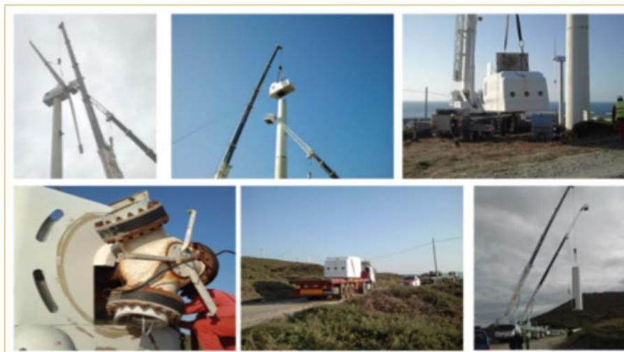
**Figura 9. Imágenes de secuencia de instalación de nuevas máquinas del mismo tipo que las que se instalaron en Cabo Vilano (ejemplo Parque Eólico Cordal de Montouto, con puesta en marcha en el año 2014)**
